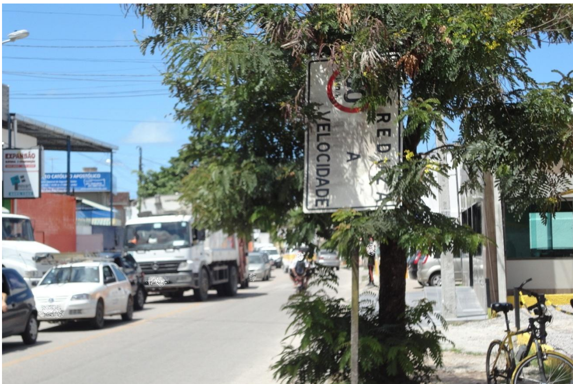
Imagem 20: placa de sinalização vertical precisando de reparos
